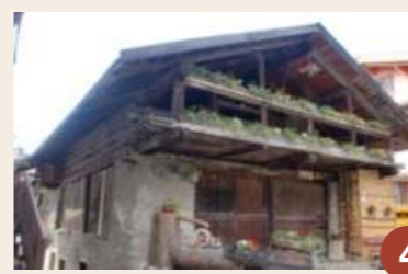
TABIA' COPETO Tipica costruzione rurale.
