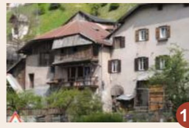
CIASA de la PREMESSARIA Antica abitazione del Primissario, prete che celebrava la prima messa del mattino
